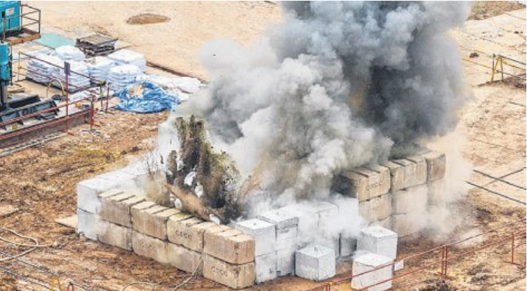
▲第一阶段的引爆使用了爆炸物炸开炸弹的外壳，烧毁炸弹的主要炸药。
